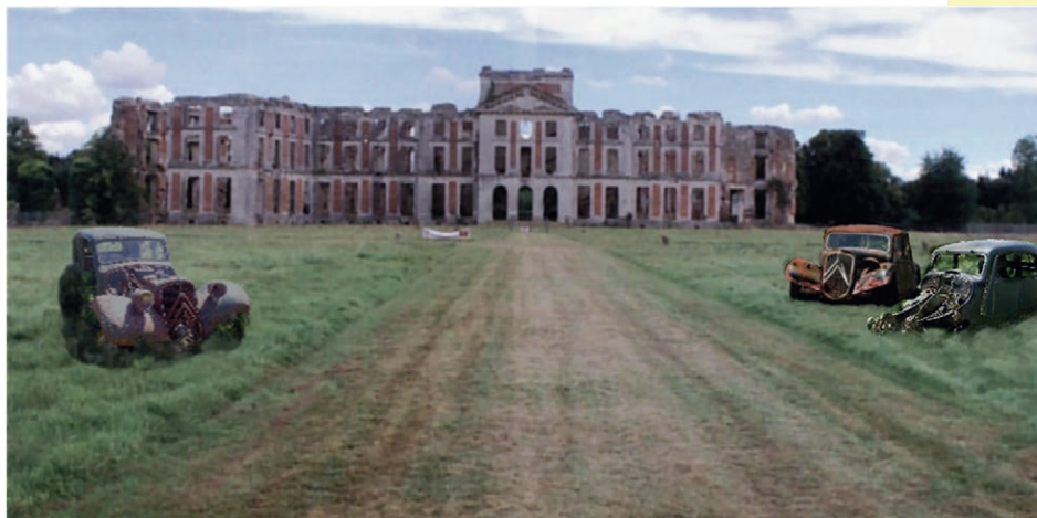
In den Wirren der Revolution bis auf die Grundmauern abgebrannt: Der Sitz des Herzog von Saint-Simon, General unter Louis XIV. Bild: garage2cv.de
