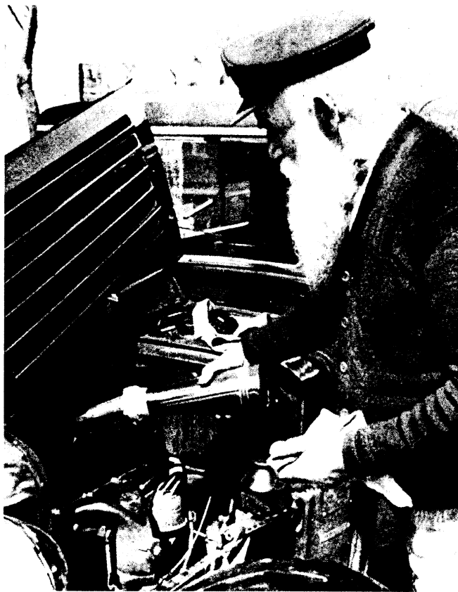
Die Einbereichs-Motorenöle der frühen Dreißiger lassen sich heute gegen sogenannte Kompressoröle ersetzen. Sie entsprechen ziemlich genau den Schmierstoffen aus Opas Zeit.
