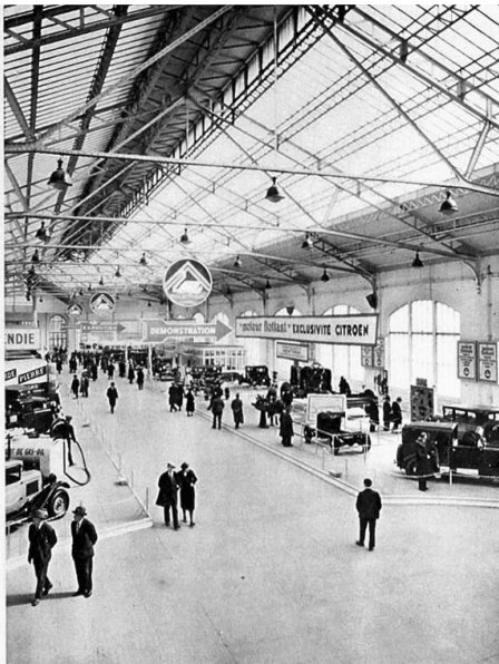
Palais des Expositions Citroën. Un côté du grand hall, vu de l'escalier central
