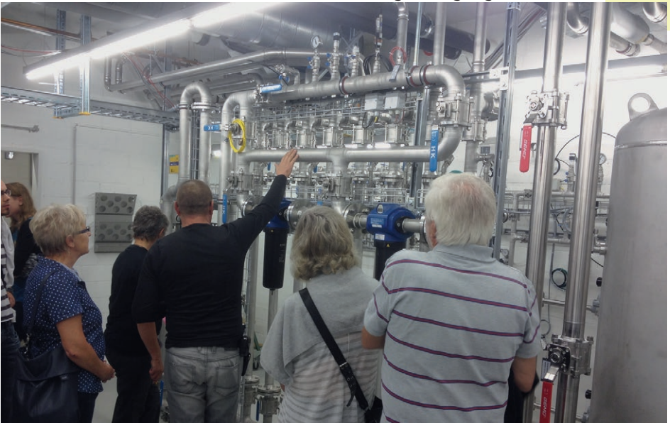
Die Hoch- und Niederdruckverteilung (43 und 8 bar) in der Druckluftzentrale
